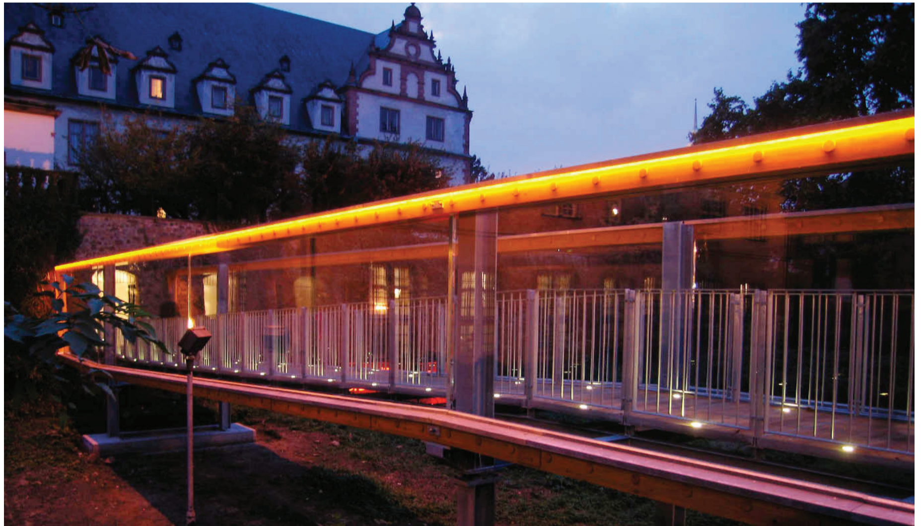
Ob sich Plexiglas zum Brückenbau eignet, wollte die TU Darmstadt mit ihrem so genannten »Wörnersteg« untersuchen. Künftig sollen andere Materialien das Plexiglas ersetzen.
