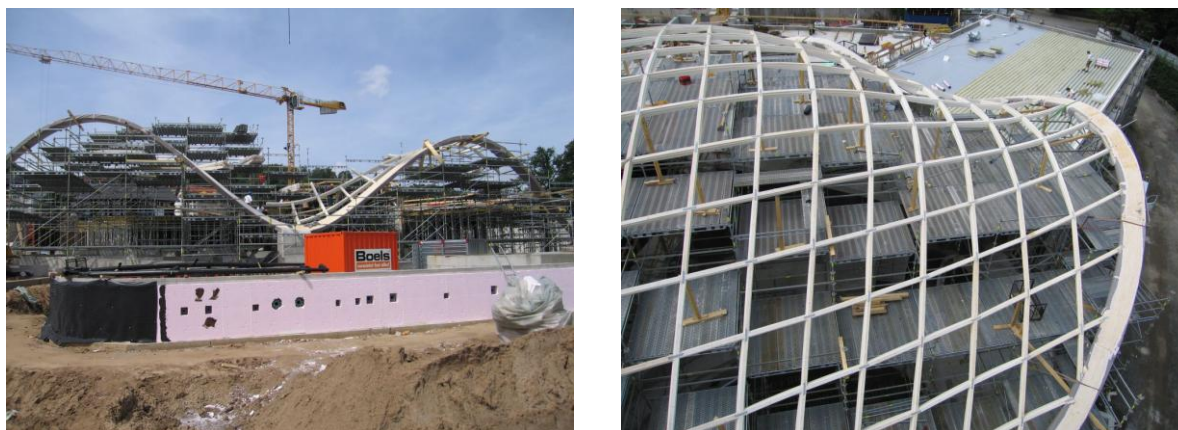
Abbildung 8: Toskana Therme Bad Orb: Montage der Dachkonstruktion auf der Baustelle
