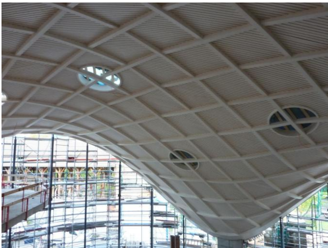
Abbildung 5: Toskana Therme Bad Orb: Innenansicht Dachkonstruktion
