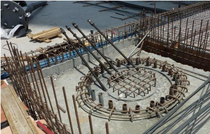
Abbildung 3: Sützenfusspunkt mit den vorbereiteten Zugankern (24 Stk. pro Stütze)
