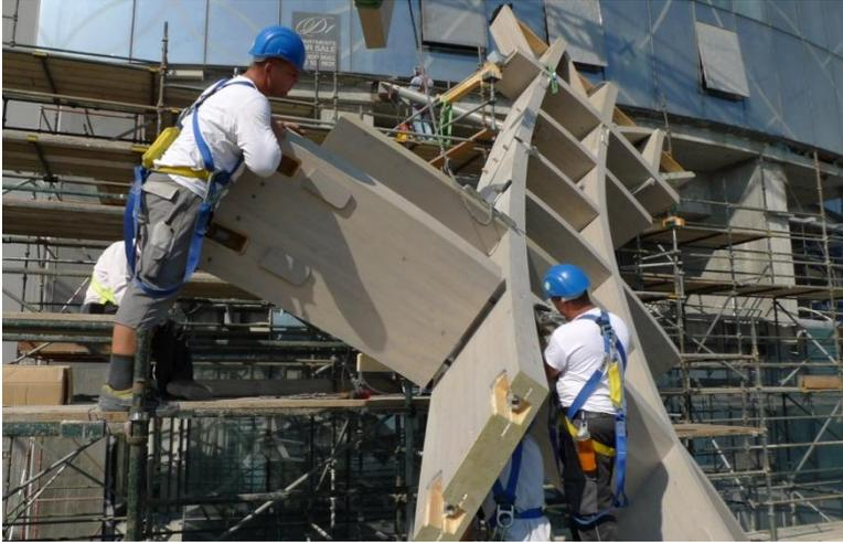
Abbildung 7: Montage der Nebenträger mittels Stecksystem
