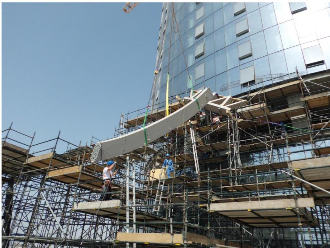
Abbildung 5: Erster Montageschritt // Fassadenbock und Hauptbinder
