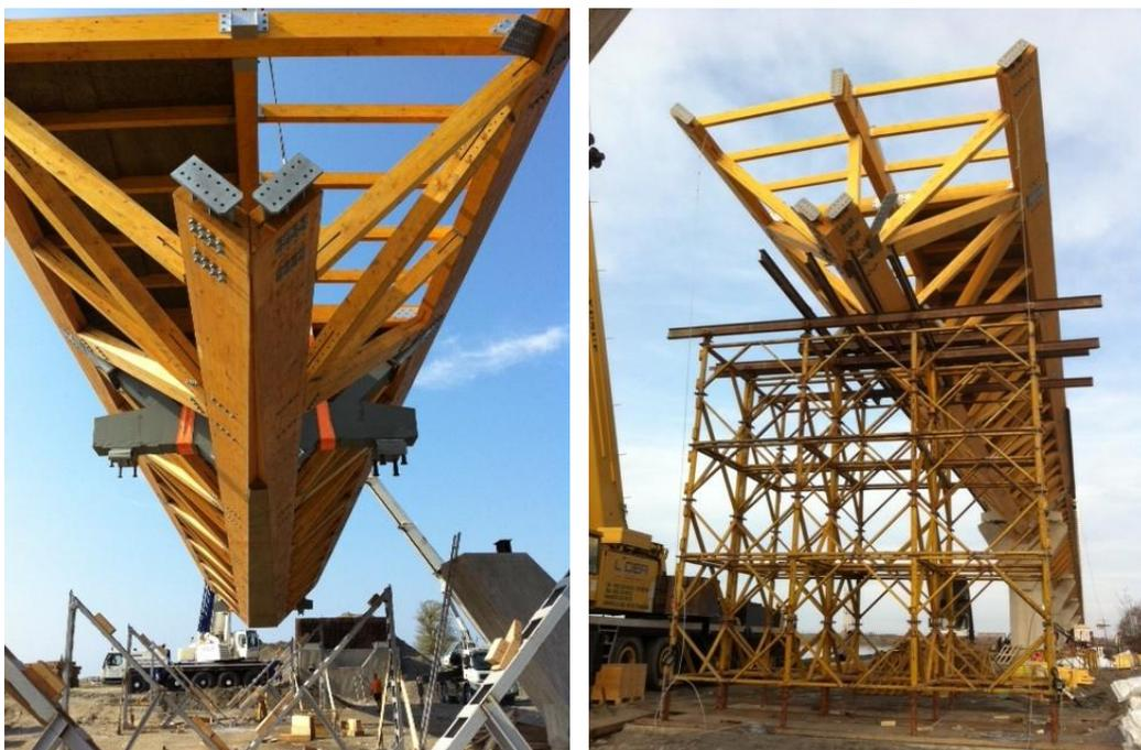
Abbildung 6: Vormontage im Hilfsgerüst, temporäre Abstützung im Schrägseilbereich der Brücke
