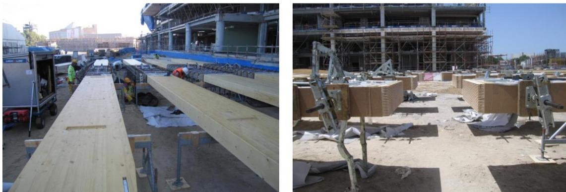
Abbildung 8: LIMITLESS Verleimungsarbeiten vor Ort in Dubai
