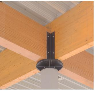
Durch die rundliche Form der Tragstruktur des Gebäudes und das komplexe Konzept standen die Architekten und Bauingenieure vor größeren Herausforderungen, die u.a. durch den Einsatz von Trägern aus Buchenfurnierschichtholz gelöst werden konnten.
