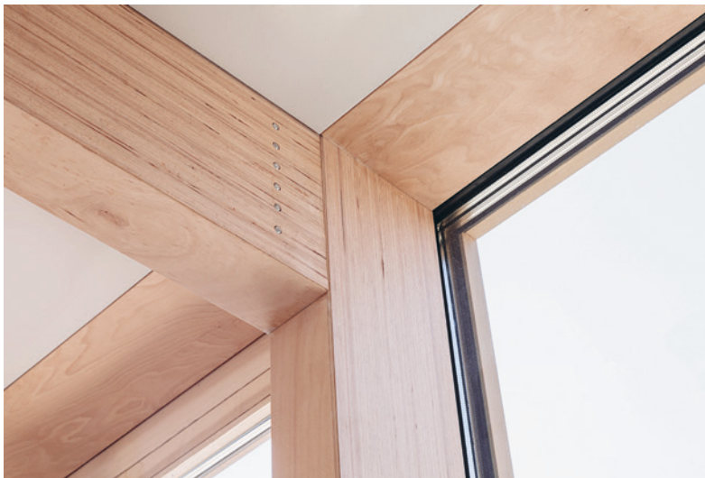
Tischlerei Anton Mohr, Andelsbuch Sichtbare Tragkonstruktion aus BauBuche Gl70 Architektur: Andreas Mohr, Tragwerksplanung: merz kley partner ZT GmbH Holzbau: Kaufmann Zimmerei Fotos: Christian Grass
