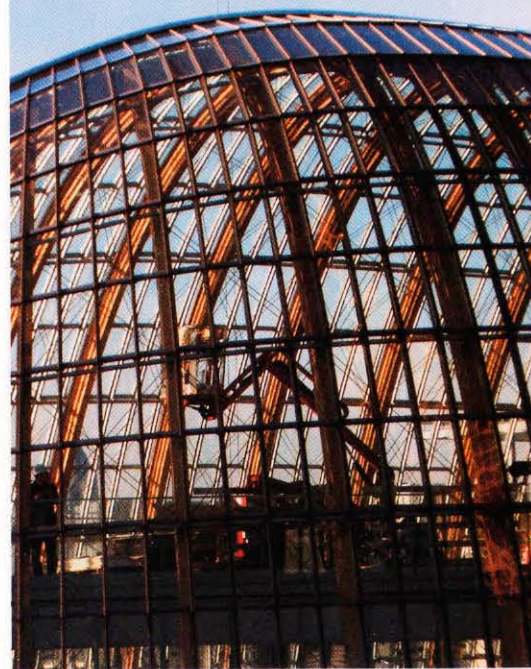
Stahlfirstträger, Holzbinder und vorgespannte Diagonalseile halten die gläserne Gebäudehülle
