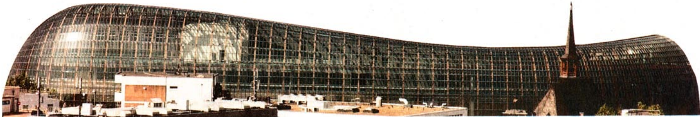
Walfisch, Schiff oder Raumschiff: Der gläserne Neubau an der Schildergasse setzt einen unübersehbaren architektonischen Akzent in der Kölner City.
