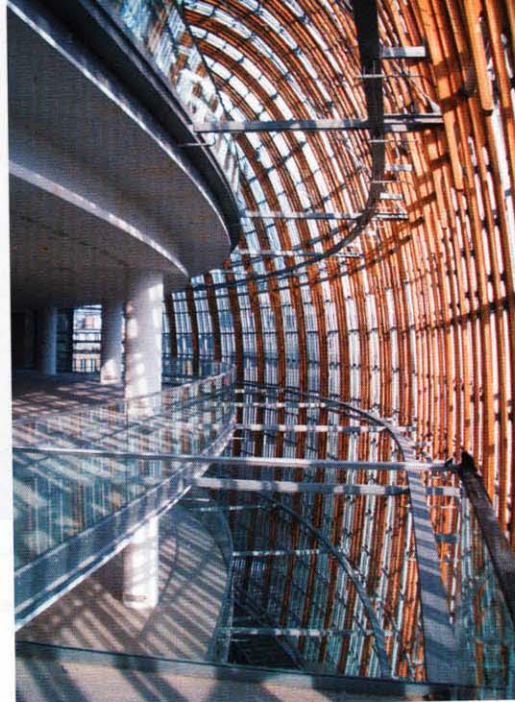
Winkelvloeren liggen op afstand van de huid (Foto: P&C, Andreas Fechner)
