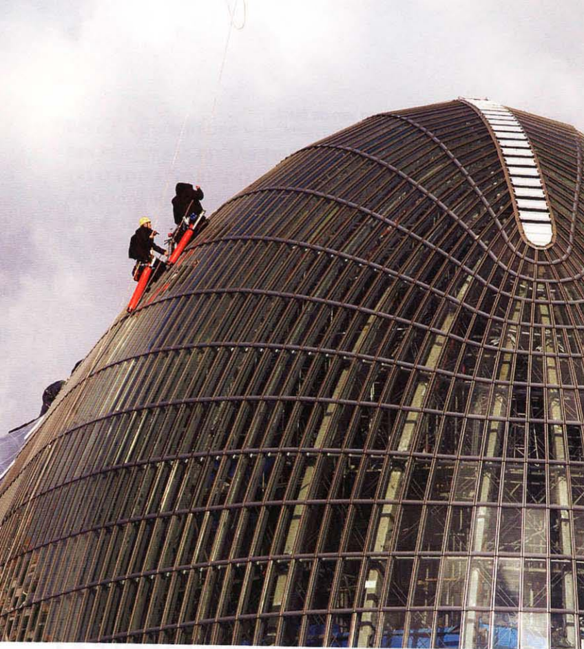
De laatste werkzaamheden op grote hoogte
