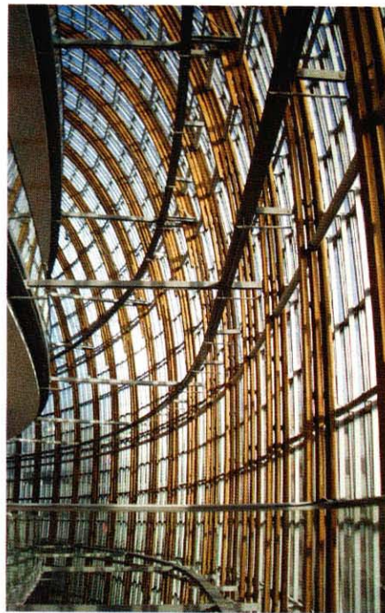
Bild 3. Innenansicht Atrium (Foto: RPBW Paris)
