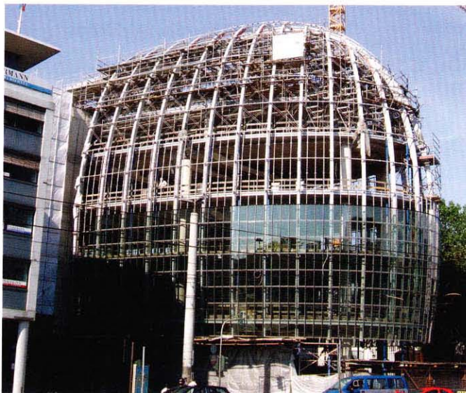
Bild 10. Montage des Tragwerkes Fig. 10. Erection of structure
