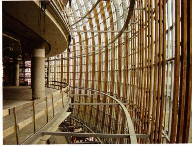
Bild 6 Im Abstand von etwa 1,20 m schwingt sich die Fassade um den Betonkern - im hängenden Bereich nur mit „Windpendeln“ gegen den Beton gestützt.
