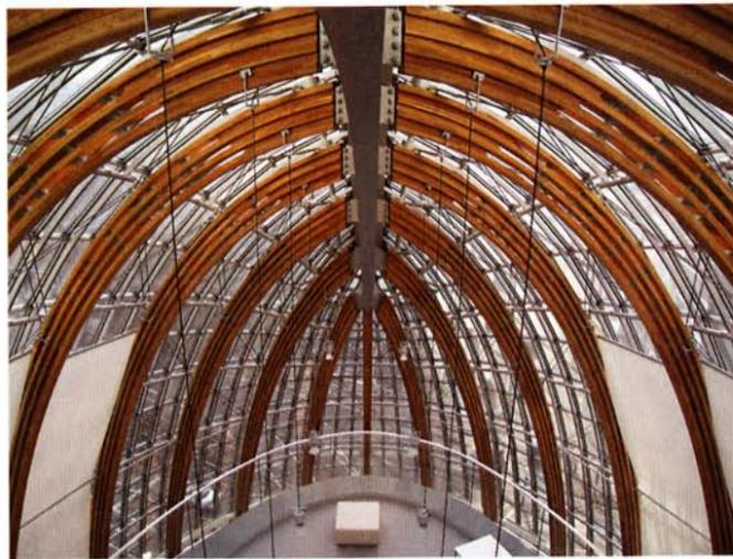
Bild 5 Obergeschoss im Kopfbau mit symmetrischer Binderanordnung. Der Firstträger ist ein 25 cm x 45 cm Hohlkasten aus Stahl.
