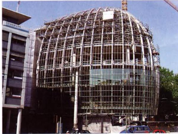
Bild 15 Die sich überlappenden Stufenisoliertglasscheiben bilden eine schuppenartige Hülle
