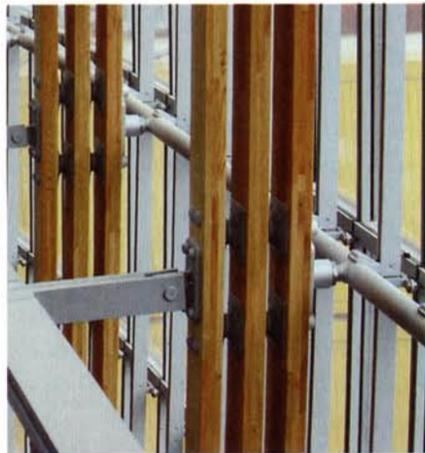
Bild 13 Außen an den Stahlrohren der Fassadenkonstruktion sind Doppelflachstähe montiert, die die Fassadenhaut aus Glashalterahmen und Dichtungsprofilen trägt.
