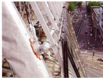
Bild 14 Die Stufenisoliertglasscheiben werden unten in die Profile eingestellt und von Deckprofilen gehalten.
