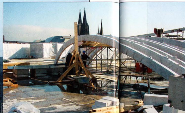
Zwischenlagerung der umhüllten Binderteile (Fotos: Hofmann)
