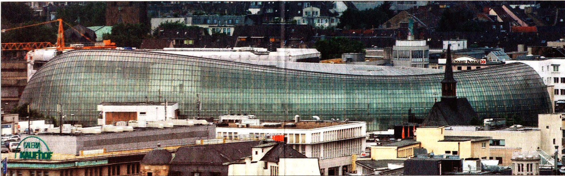
Der Glaskuppelbau des jetzt ausgezeichneten „Weltstadthaus“ in Köln stammt von dem italienischen Architekten Renzo Piano
