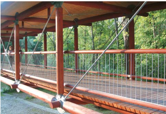
Lärche-Säulen für Fußgänger-Brücke über Isar in München
