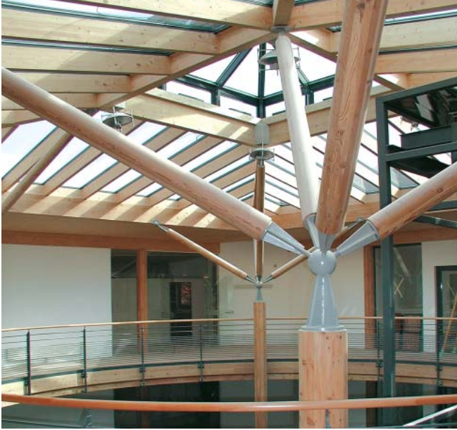
Lärche-Säulen ÖBF-Verwaltung in Purkersdorf
