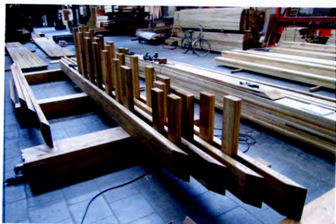
Nach einer genauen Vorplanung wurde das Bauwerk in der Werkhalle elementweise vorgefertigt.
