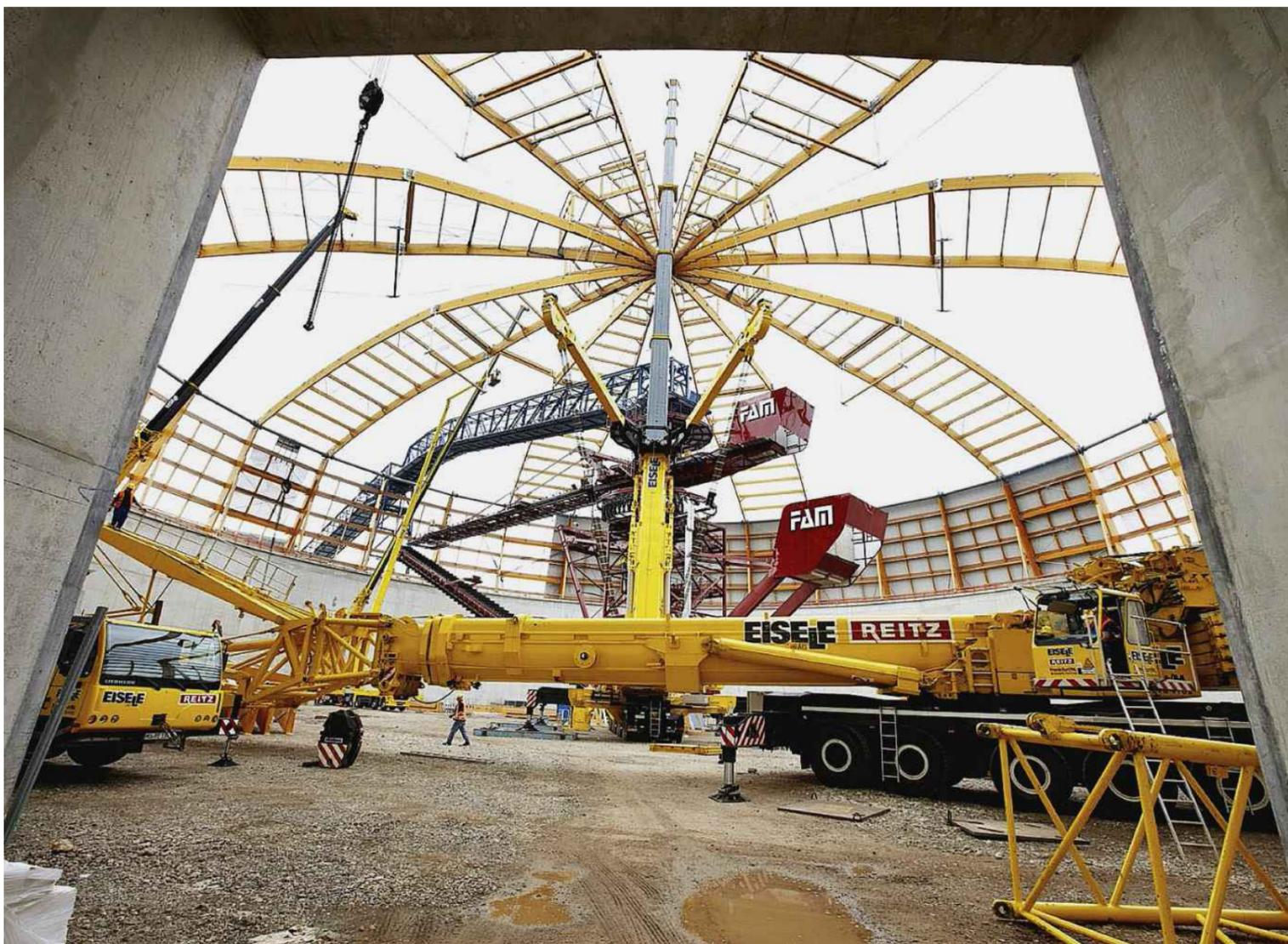
Eine ausgeklügelte Konstruktion aus Fichtenholz-Leimbändern, hergestellt von der Firma Hess Wohnwerk in Kleinheubach, ist Kern des Kuppeldachs über dem neuen Kohlelager bei Staudinger. Foto: privat
