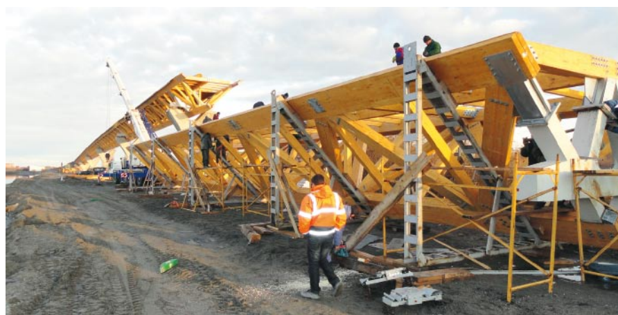
Nach der Vorfertigung in Deutschland und dem Transport ans Ostufer des Schwarzen Meers wurden die Gurte und die übrigen Fachwerkkomponenten auf einem eigens dafür aufgeschütteten Damm montiert und später an ihren endgültigen Platz gehievt.
