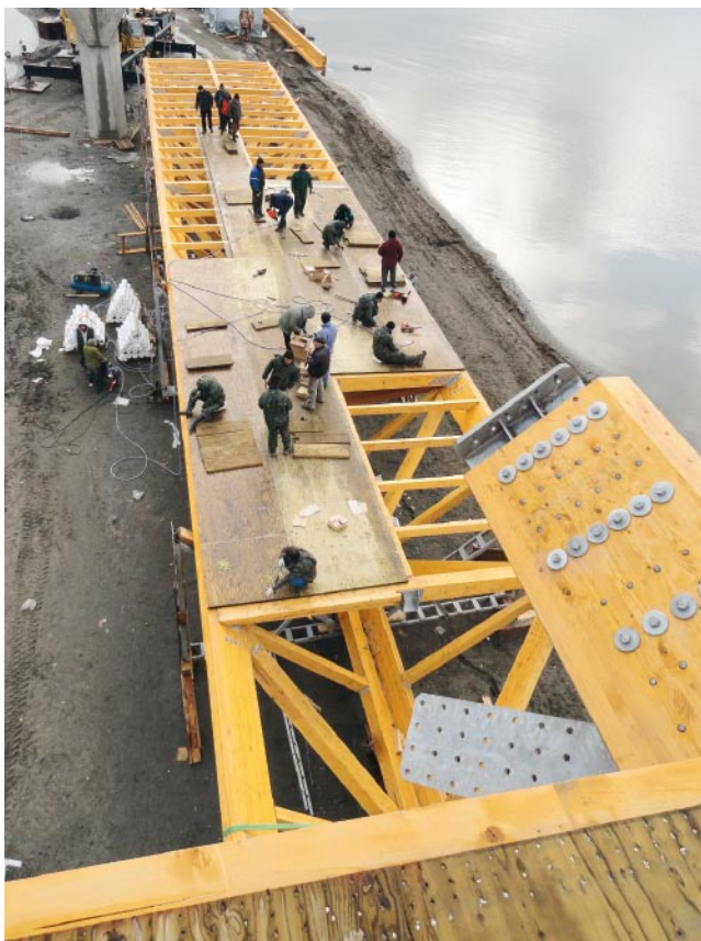
Kerto-Q-Platten bilden als horizontale Scheibe das Aussteifungselement. Gleichzeitig sind sie die Laufplatte der Brücke. Die Abdichtung erfolgte mit einer glasfaserverstärkten PVC-Bahn von Wolfin.
