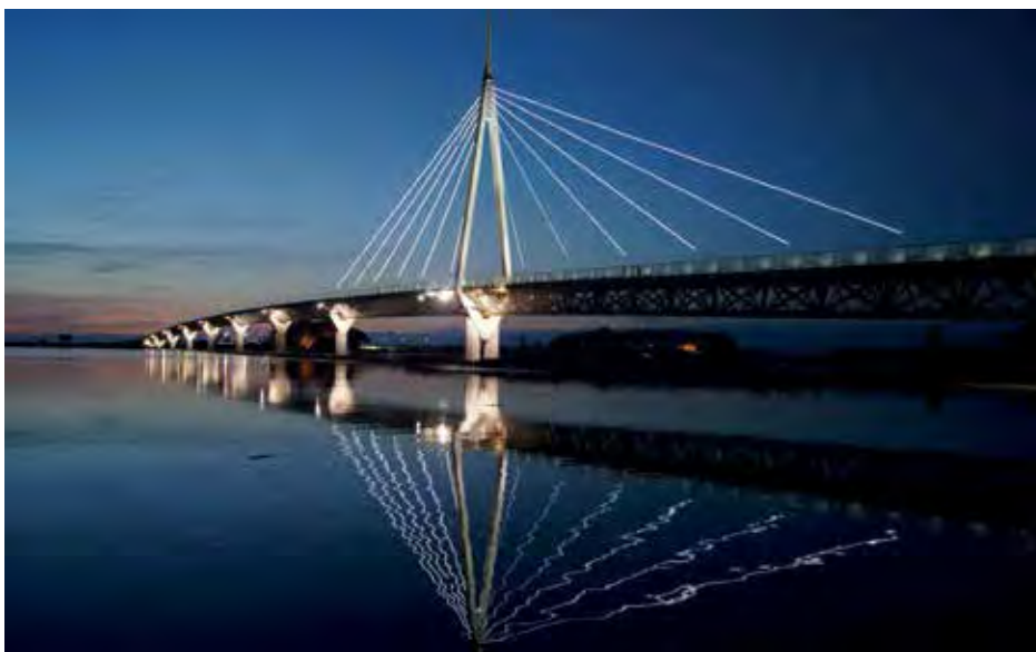
19 Fußgängerbrücke in Anaklia nach Fertigstellung © Caucasus Road Projekt
