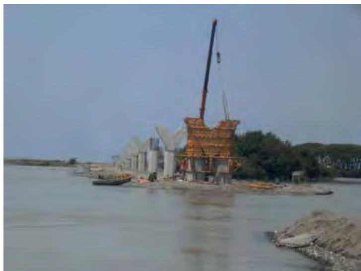
12 Herstellen von Pfeilern und Pylon © Hess Timber GmbH & Co. KG
