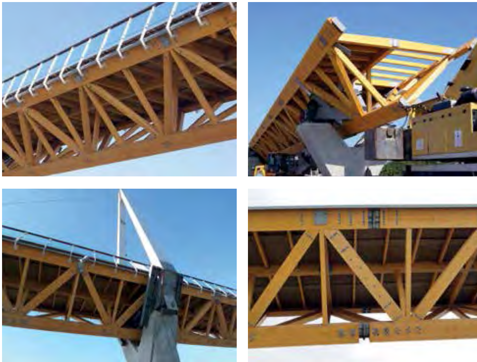
15 16 17 18 Bauzustand: Fachwerk, Anschluss von W-Rahmen und Pylon sowie Segmentstoß © Hess Timber GmbH & Co. KG
