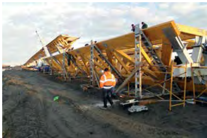
14 Vormontage des Überbaus © Hess Timber GmbH & Co. KG
