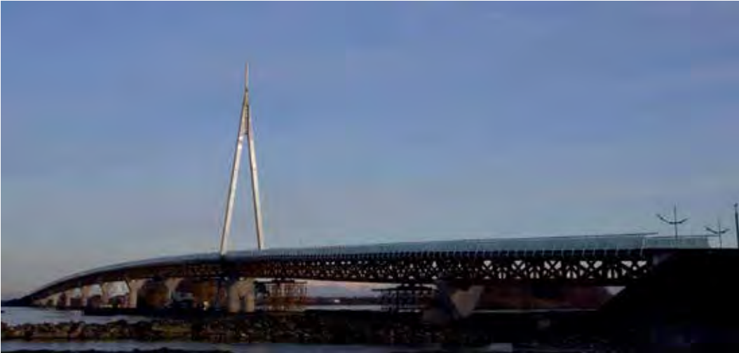
13 Überbau auf Hilfsstützen © Hess Timber GmbH & Co. KG
