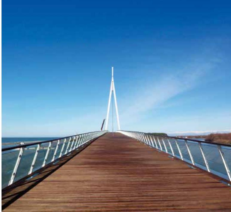
Die Anaklia-Brücke ist als zweifaches, in Brückenmitte geteiltes Mehrfeldsystem konzipiert. Im Detail besteht sie aus zwei gevouteten Widerlagerbereichen mit je 36 m Spannweite, sechs „Regelbereichen“ mit jeweils 48 m Länge und dem Schrägseilbereich mit den größten Spannweiten von 60 m und 84 m. Ihre Gesamtlänge beträgt 504 m.
