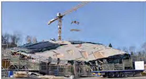
Die erste Lage Dreischichtplatten wird auf einer Hilfskonstruktion verlegt. In der zweiten und dritten Lage sind die Öffnungen für die Oberlichter bereits ausgeschnitten. Foto: Walt + Galmarini
