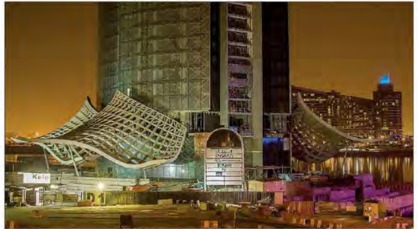
Vordächer für den D1-Tower in Dubai: Die Bewältigung der Geometrie, die daraus resultierende Vielzahl an Holzbauteilen und Anschlüssen der frei geformten Gitterschalen aus BS-Holz war auch eine logistische Herausforderung. Foto: Hess Timber
