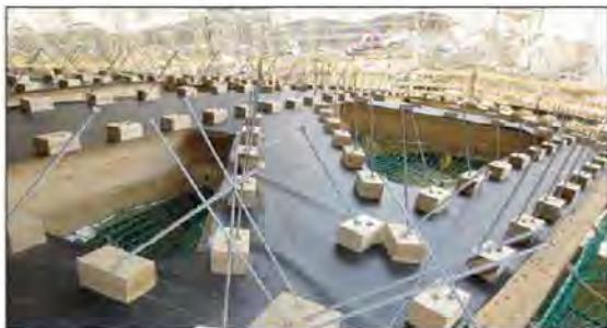
Die Holzklötze zur Ausbildung der Installationsebene der Elefantenhauskuppel sind gleichzeitig Positionierungs- und Führungshilfe für die Spezialschrauben, mit denen der Verbund der Dachschalen hergestellt wird. Foto: Walt + Galmarini
