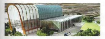
Seit Oktober 2013 befindet sich in Leeds, Grossbritannien, eine neue Hightech-Müllverbrennungsanlage im Bau. Die Arbeiten sollen Mitte 2016 abgeschlossen sein. Die Anlage soll mit 42 Metern das höchste und wahrscheinlich auch das grösste Brettschichtholzgebäude des Landes sein. Der Entwurf der Hightech-Anlage stammt aus der Feder von Jean-Robert Mazaud vom renommierten Büro
