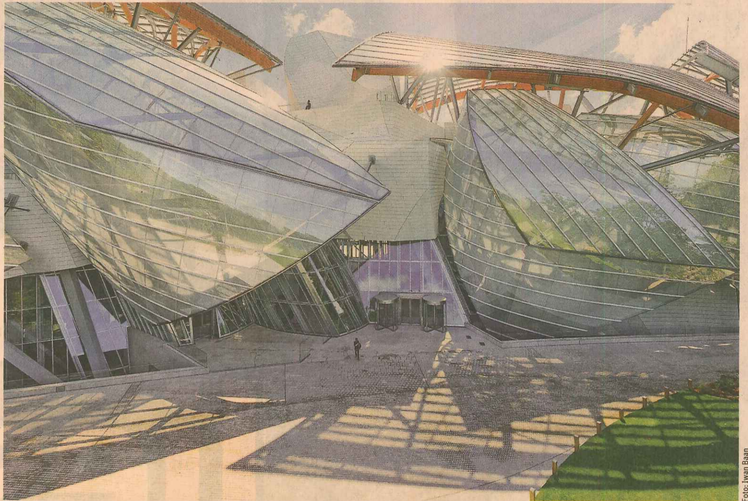
Der amerikanische Stararchitekt hat im Bois de Boulogne ein Segelboot mit zwölf riesigen Glassegeln anlanden lassen. Weitere Insignien: gewaltige Stahlträger und Holzleimbinder. Viel Luft, viel Show, viel Konstruktion.
