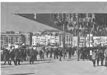
Seite 1172 / page 1172 Pavillon am Vieux Port in Marseille The Vieux Port Pavillon in Marseille
