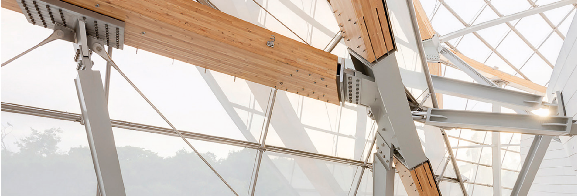
270t Duplex-Stahlbauteile halten die Segel zusammen. Das Gesamtvolumen an BSH-Trägern summiert sich auf 800m³.
