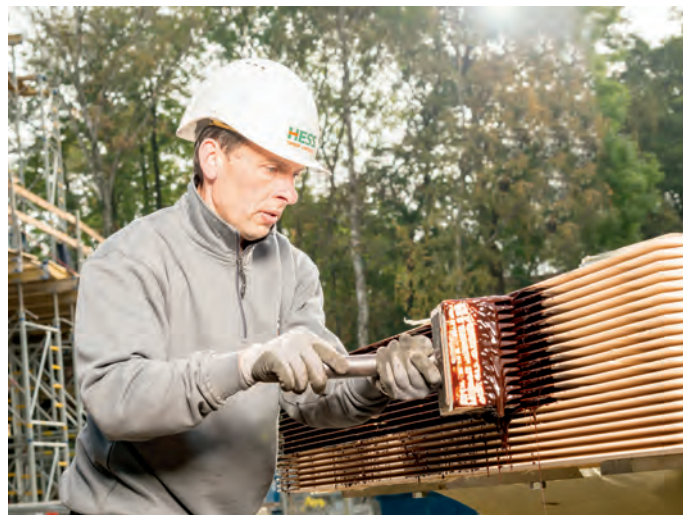
Verklebungsarbeiten vor Ort auf der Baustelle in Palanga
