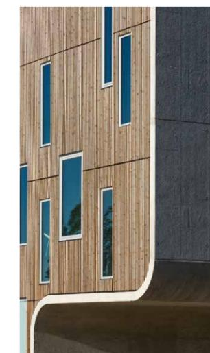
▲ Le revêtement de mélèze en façade des blocs de bureaux est composé de lames de pin traitées thermiquement de 40 mm x 40 mm.
