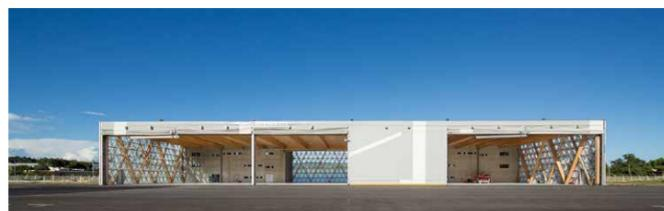
▲ Six portes textiles motorisées d'une surface ouvrante de 1 200 m<sup>2</sup> ferment la grande salle.
