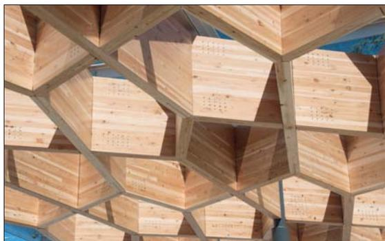
Aufwendige, aber effektvolle Gestaltung: Unzählige unterschiedlich geschnittene Holzplatten, die über eingeschlitzte Bleche und Stabdübel verbunden sind, bilden die Wabenkonstruktion
