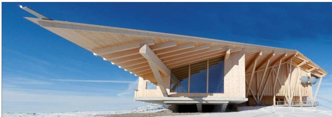
Mit dem neuen Gipfelgebäude auf dem 2262 m hohen Chäserrugg\*\* haben die Architekten einen markanten Holzbau gestaltet. In ihm kommen die Bergstation der Seilbahn, ein Restaurant und verschiedene Veranstaltungsräume unter. Ins Auge fallen besonders die weit auskragenden Pfetten. Streben stützen sie gegen den Stahlbetonunterbau bzw. gegen die Fachwerkpfosten ab
