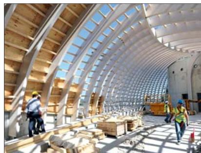
Jeder BSH-Bogen hat eine andere Geometrie. Zur Erzeugung der organischen Gebäudeform war die exakte Ausrichtung der Stahlteile im Fundament für die Anschlüsse der Bogenfußpunkte entscheidend
