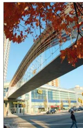
Die Fußgängerbrücke „Kingsway Bridge“ in Burnaby (Kanada) aus dem Jahr 2008 ist ein Beispiel für die Aufwertung einer tristen Umgebung durch Holzbauten. Die Gehbahn ist an den doppelt gekrümmten Brettschicht-Holzträgern aufgehängt. Im Bogenstich gebündelt spreizen sie sich zum Auflager hin auf
