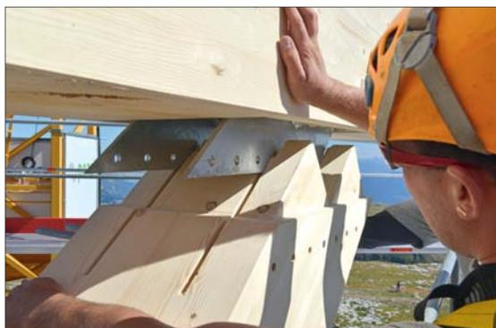
Für hochtragfähige Bauteilverbindungen wurden beim Gipfelgebäude auf dem Chäserrugg zimmermannsmäßige Anschlüsse mit eingeschlizten Blechen und Stabdübeln kombiniert
