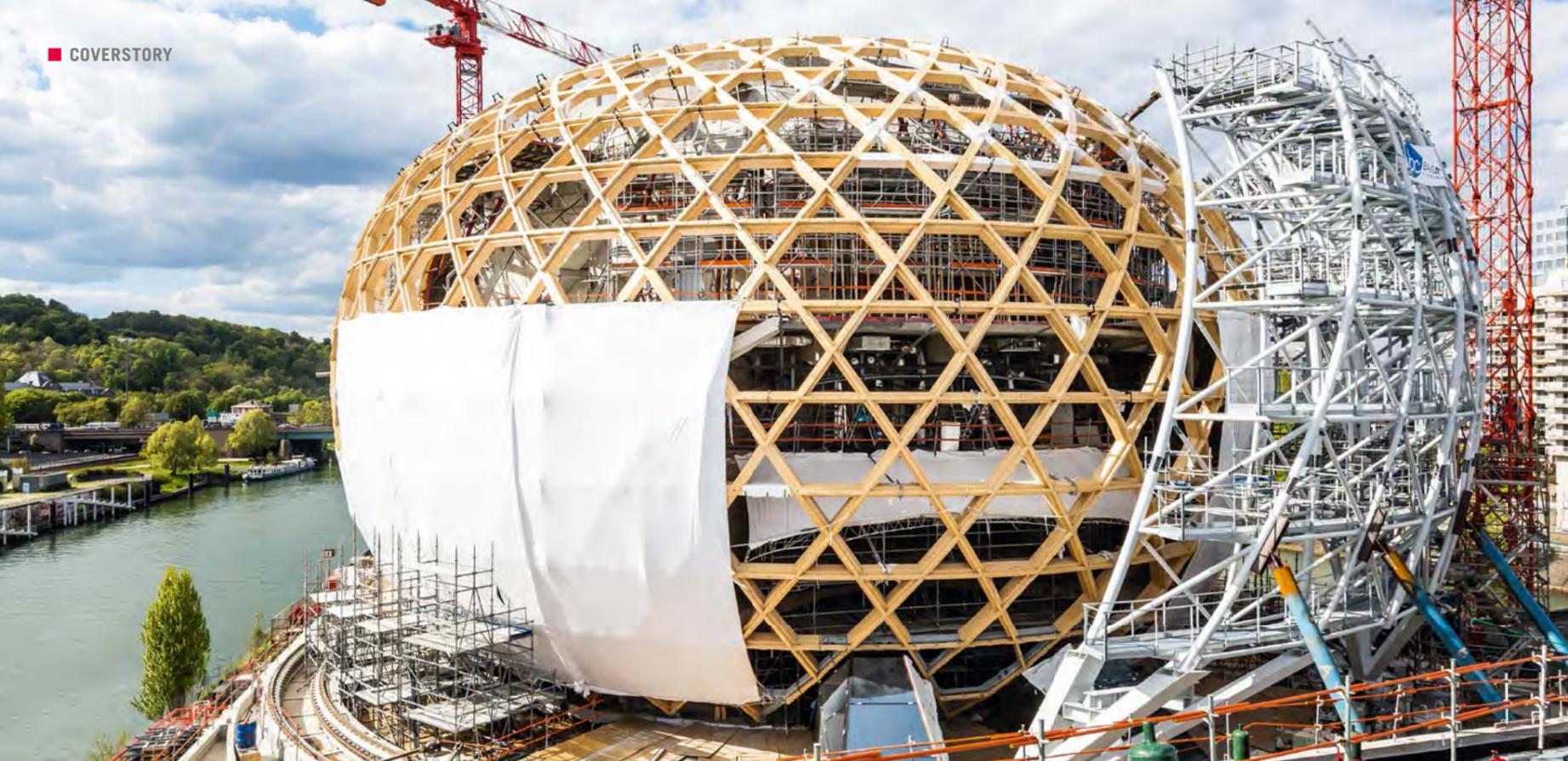
Rund 70 m in der Längsachse sowie 45 m in der Querachse misst der Holzglobus des Auditoriums – 1700 individuell gefertigte Einzelelemente waren dafür notwendig.
