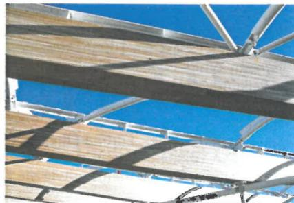
11 freischwebende Balken tragen die Überdachung und formen die Primärstruktur des Daches
