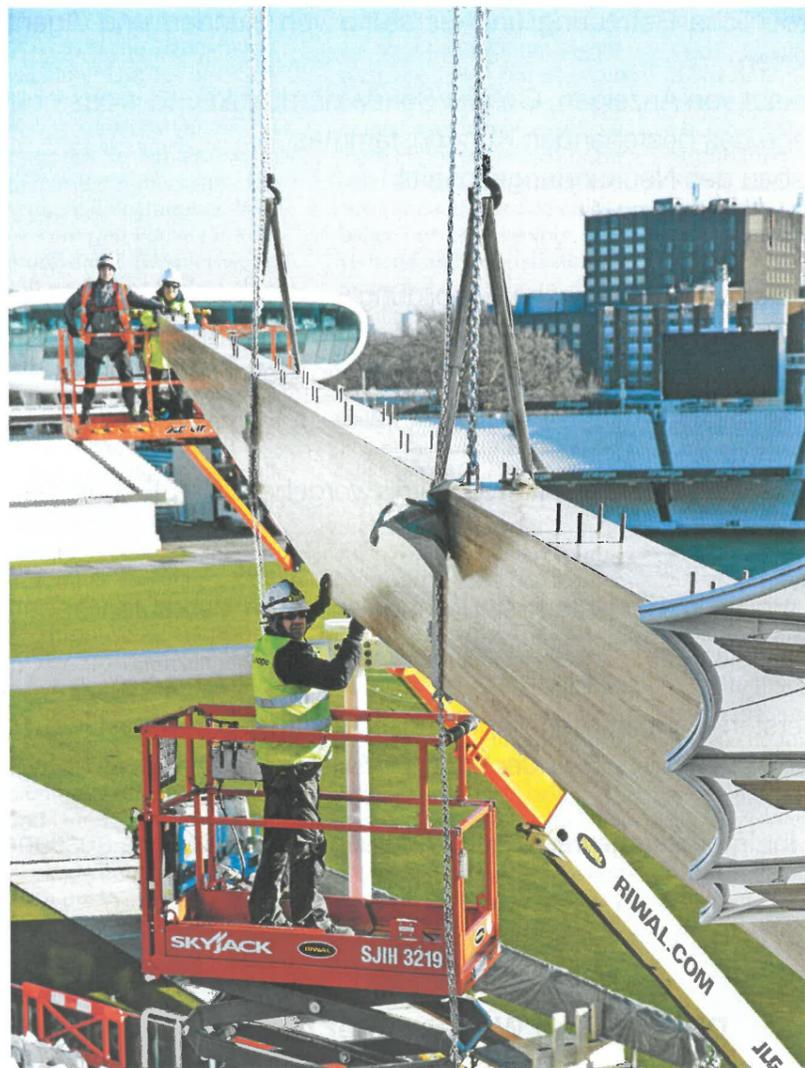
ponentielle Art von der Ecke des Platzes aus und ebnen so den Weg für eine gewagte neue bautechnische Verwendung nachhaltiger amerikanischer Laubhölzer; die Balken wurden in Deutschland von Experten für Brettschichtholzerstellung von der Hess Timber GmbH & Co. KG, Kleinheubach, gefertigt.
