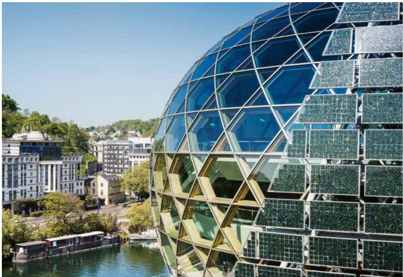
Die transparente Holzkonstruktion wird partiell durch das sich drehende PV-Segel abgedeckt.
