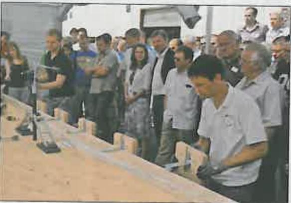
Vorführung der neuen Keilzinkenverbindung „Hess-Patentstoß Limitless“: Hier wird der lange Schäftkeil in Position gebracht, der zwei BSH-Teilträger am Stoß miteinander verbindet.
