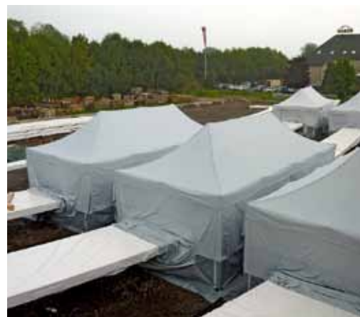
Verleimung in der Zeltstadt: Beheizte Zelte schützen die Stoße vor der Witterung
