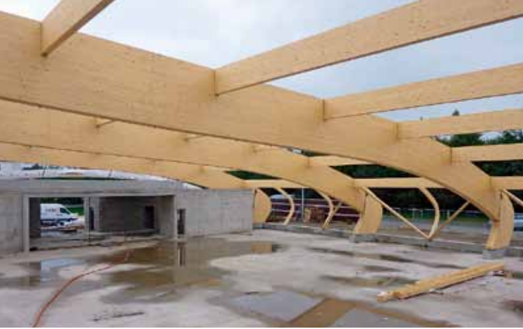
Die bis 55 m langen Träger dieses Sporthallen-Rohbaus in Luxemburg wurden auf der Baustelle verleimt
