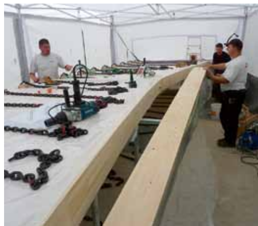
In kontrollierter Umgebung wird entpackt, geprüft, verleimt und mit Muskelkraft verpresst
