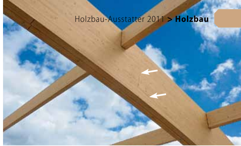
Bei den ersten Projekten verwendete man für die Verklebungen dunkles Resorcinharz – die senkrechten Stellen werden jetzt mit UF-Harz verklebt
